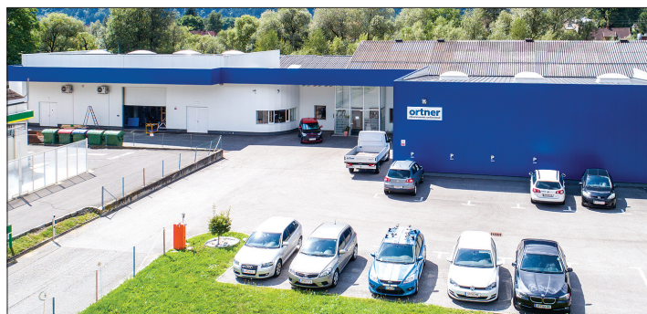
Das Betriebsgelände in Möllbrücke wurde im Laufe der letzten Jahre ständig ausgebaut und modernisiert.
